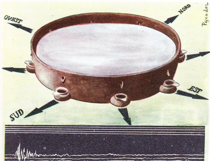
En haut, le sismographe de l'Abbé de Haute-Feuille, constitué par une bassine emplie de mercure jusqu'à hauteur des différentes bouches, orientées selon les points cardinaux. La secousse tellurique fait couler le mercure dans les petites coupes, ce qui indique l'orientation et l'ampleur d'un tremblement de terre. En bas, sismogramme d'un tremblement de terre distant de 200 km environ.
